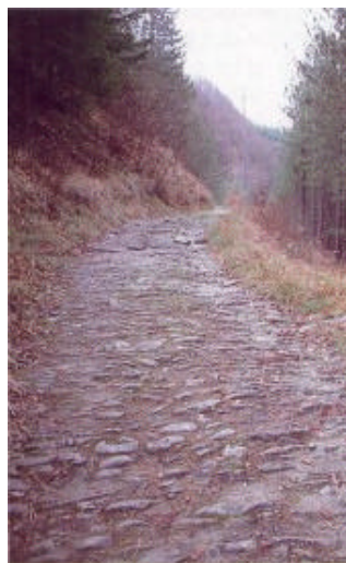
Un tratto di Strada Fiorentina in località Ridolla
